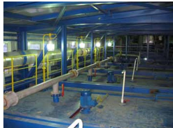
Применение светильников с ртутными лампами позволяет уменьшить общее количество светильников по сравнению с светильниками с лампами накаливания, так как их светоотдача в 2,5раза больше. Кроме того, ртутные лампы имеют больший срок службы, чем лампы накаливания. Таким образом, количество замен ламп уменьшается, и соответственно уменьшаются эксплуатационные расходы.
