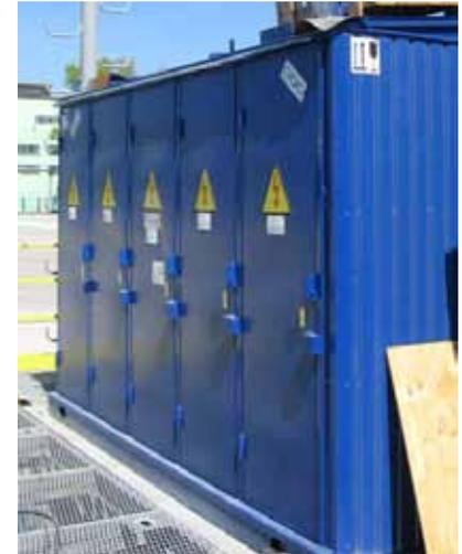
**КРУ 1** установлено в модуле КРУ буровой установки в эшелоне и передвигается при передвижке буровой установки вместе со всем эшелонном.
