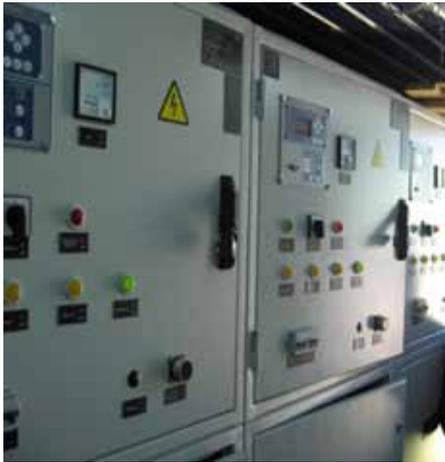
Для распределения электроэнергии напряжением 6кВ на буровой установке применены два комплектных распределительных устройства КРУ1, КРУ2, КРУ3(верхний привод)
