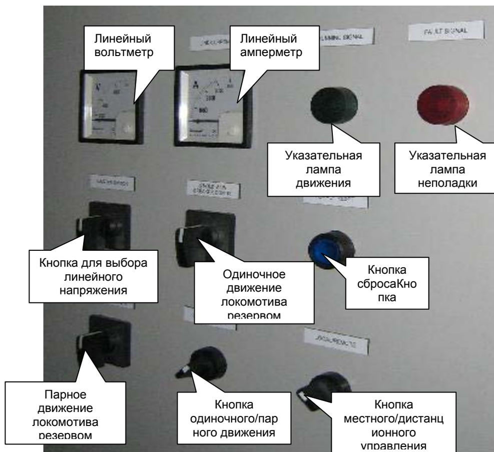
Схема 4-1 Компоновка выпрямительного шкафа
