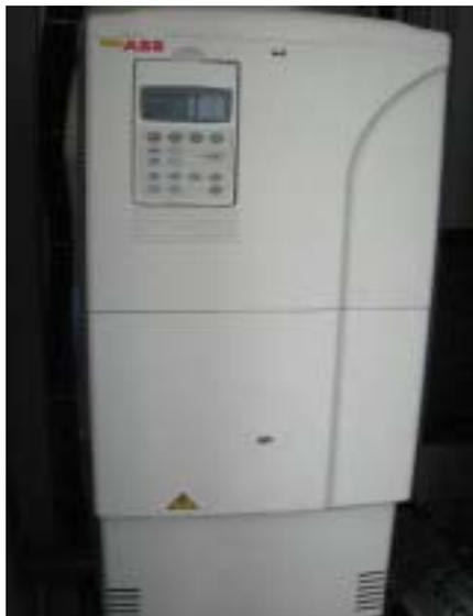
Схема 2-8 Преобразователь частоты
