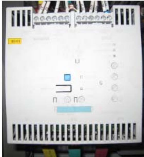
Схема 2-9 Стартер мягкого пуска
